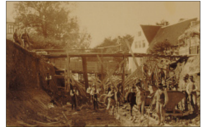
Fæstningskanalen under udgravning ved Lyngby Hovedgade 1887
